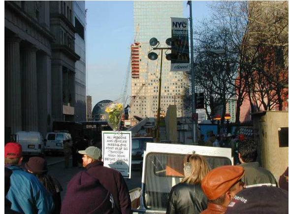
写真3 工事中の「展望台」
