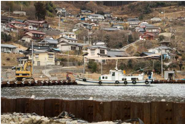
写真1 地盤が下がり海水が迫る鮪立の集落
