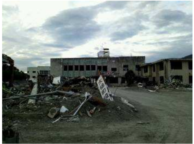
写真 1 被災した大槌町役場
